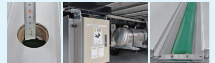
エア供給口穴あけ コントロールBOX・エアータンク取付 コンベアホース設置
